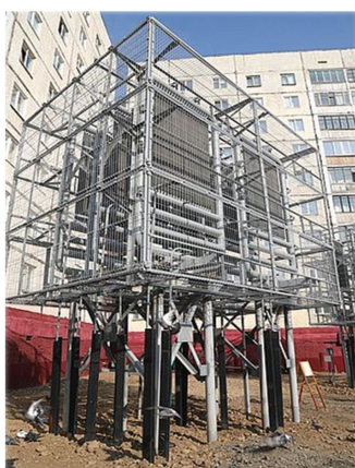
Рис.4. Работы по дополнительной термостабилизации грунтов в основании существующего реконструируемого здания.
