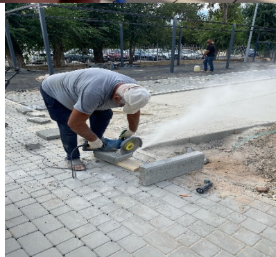
Рисунок 2;3 – Работа угловой шлифовальной машиной
