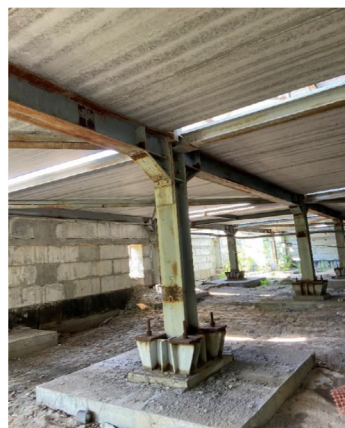
Рисунок 3 – Общий вид подвального этажа на отметке -3,300
