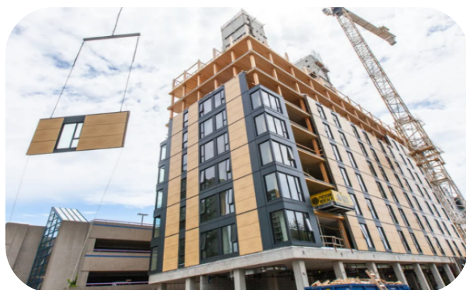
Рис.3. Пример строительства «легкого» деревянного многоквартирного дома на многолетнемерзлых грунтах.
